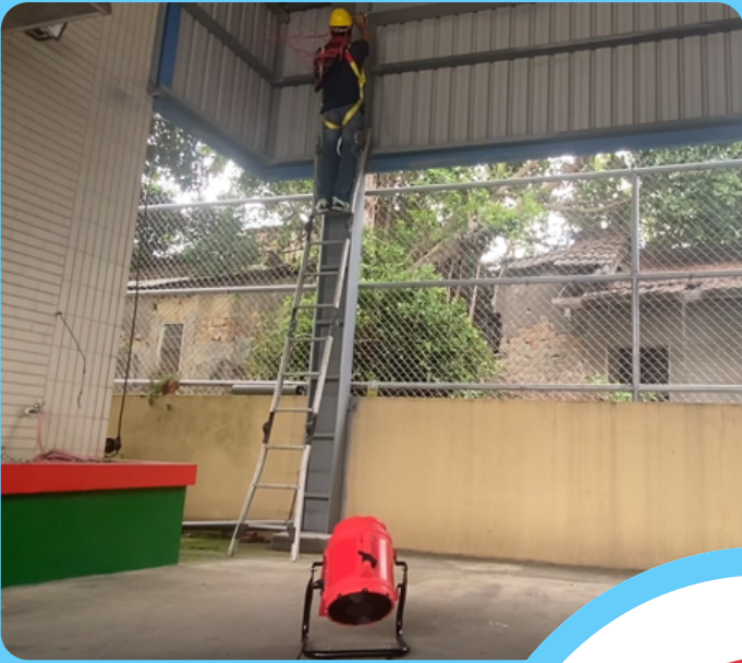
高所作業のための送風
