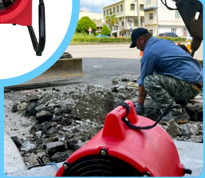
屋外工事の送風
